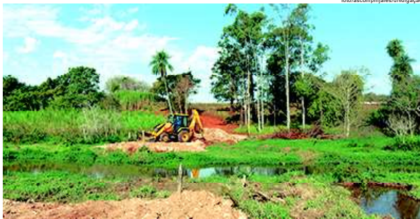
A construção da ponte está em andamento, pronta irá favorecer os produtores
