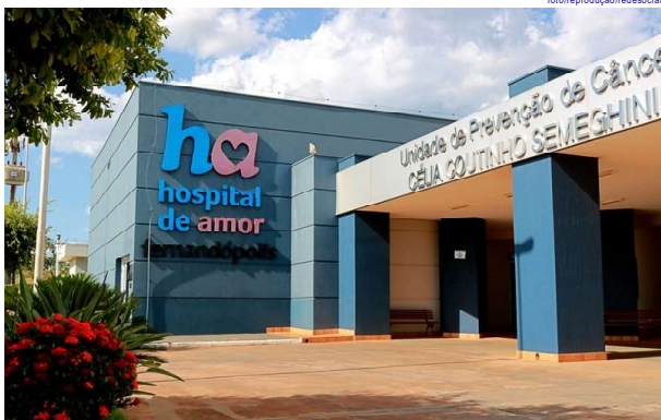
A concretização do CER II em Fernandópolis consolida um esforço conjunto para descentralizar a saúde de alta complexidade no Noroeste Paulista.
