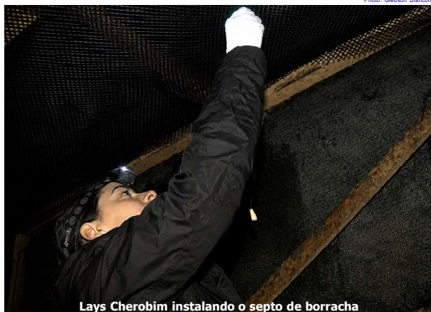
Lays Cherobim instalando o septo de borracha
